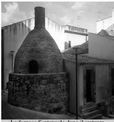
La fornace Santangelo dopo il restauro
